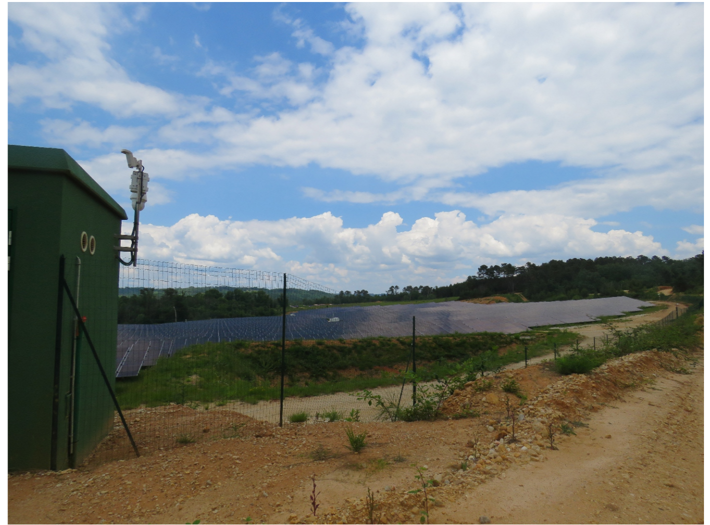
Etat final du site
